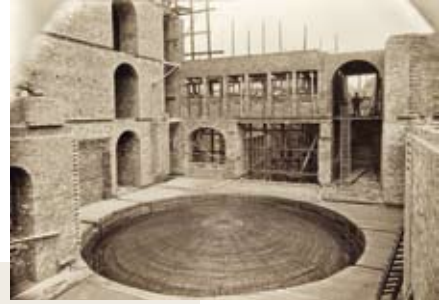
Abb. 15 Die Eisenbetondecke der Rotunde im Rohbau.
