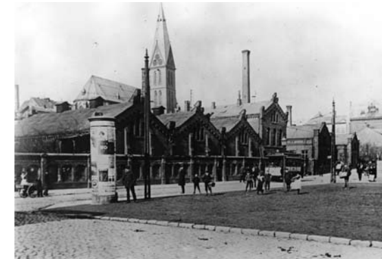
Abb. 5 Die Gasanstalt an der Fleethörn wurde 1855 auf Initiative des Kaufmanns Wilhelm Ahlmann errichtet. Dahinter ist die St.-Nikolaus-Kirche von 1893 zu sehen.
