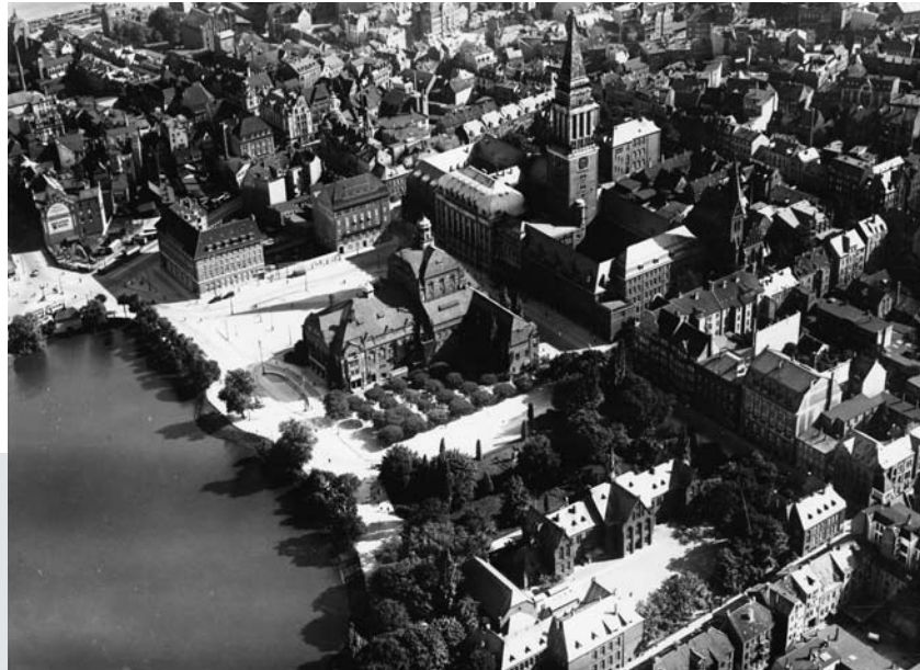
Abb. 39 Die Luftaufnahme zeigt den Neumarkt mit Stadttheater und Rathaus. Im Vordergrund ist das Königliche Gymnasium zu sehen.
