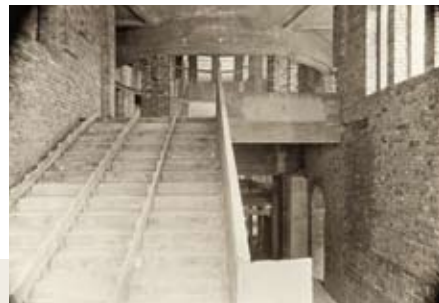
Abb. 16 Die Haupttreppe im Betonrohbau.
