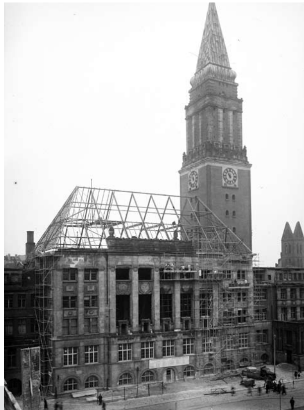
Abb. 53 Beim Wiederaufbau 1948–1950 bekam der Mittelbau ein einfaches Walmdach.
