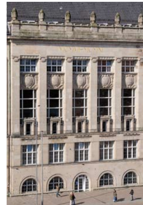
Abb. 21 Die Fassade des Mittelbaus ist mit behauenen Sandstein verkleidet. Die weich geformten Ornamente sind charakteristisch für Hermann Billing.
