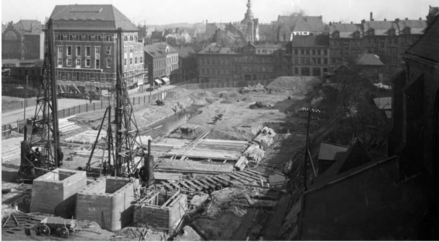
Abb. 13 Fundierungsarbeiten: Vorne links die beiden Dampfrahmen und die Betonbrunnen für die Turmfundamente. Links der Neumarkt, vorne rechts die St.-Nikolaus- Kirche.
