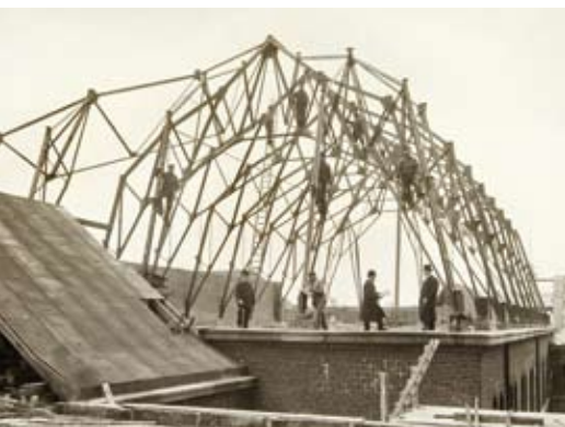
Abb. 18 Das Eisengerüst für die Kupferverkleidung des Mittelbaus, vermutlich im Herbst 1909.
