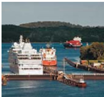
Schleuse am Nord-Ostsee-Kanal
