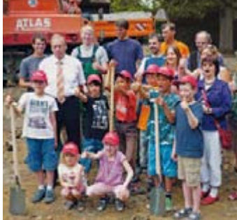
Umgestaltung des Kinderspielplatzes Geibelplatz. Der erste Spatenstich in Anwesenheit von Kita-Kindern.
