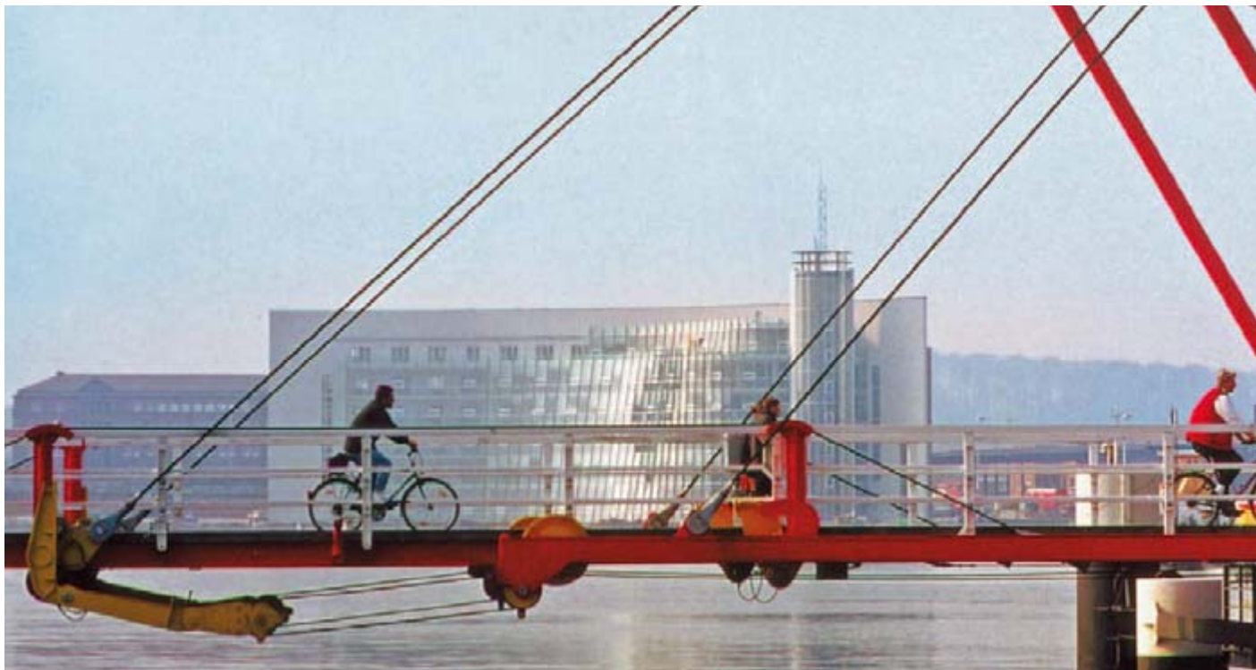
Hörnbrücke mit Blick auf den Hörn-Campus
