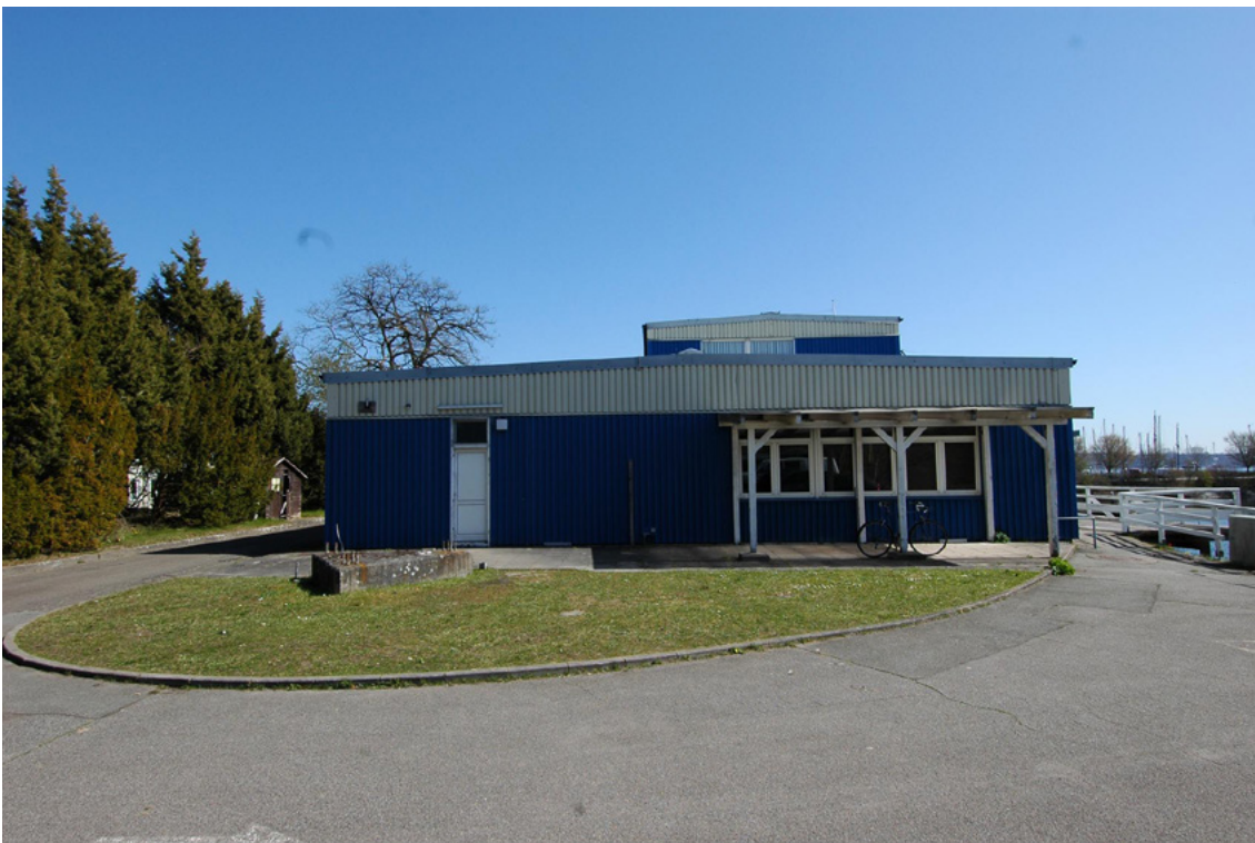
Abbildung 17: Gebäude B3a, Kantine, Ostfassade
