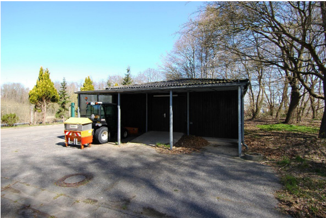
Abbildung 11: Gebäude B2, Lagergebäude, Westfassade
