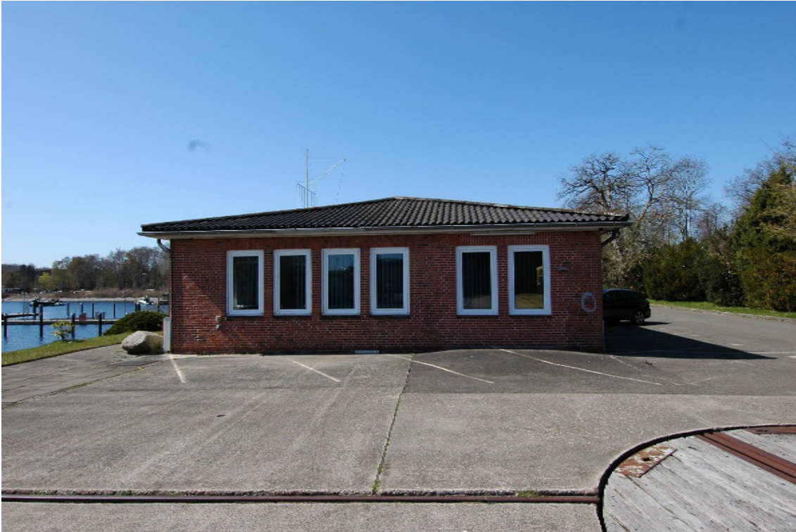
Abbildung 25: Gebäude B3, Bürogebäude, Ostfassade
