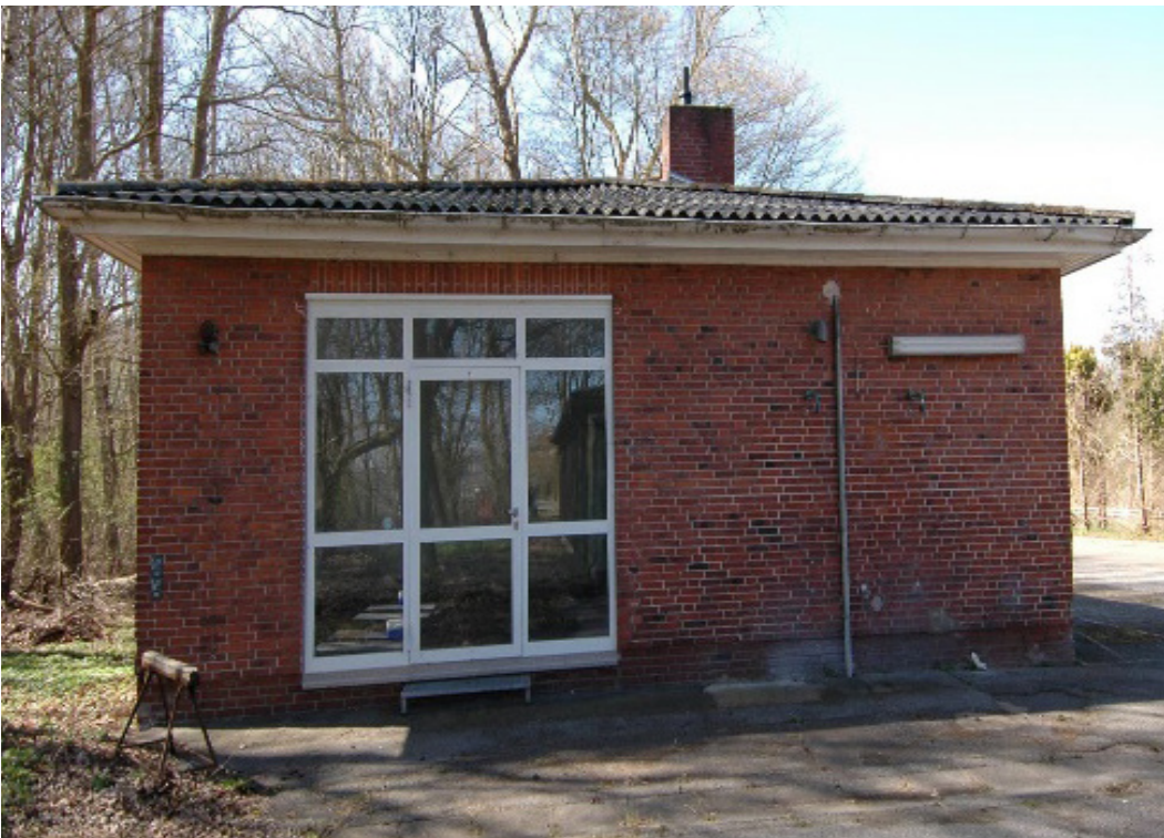
Abbildung 3: Gebäude B1, Schulungsgebäude, Ostfassade
