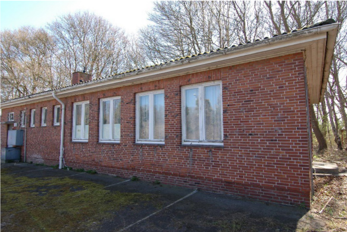
Abbildung 2: Gebäude B1 Schulungsgebäude, Nordfassade
