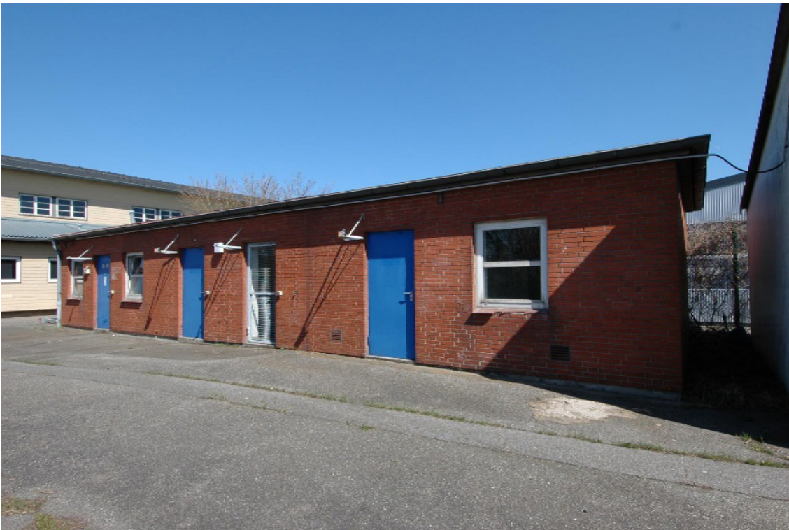
Abbildung 38: Ehemaliges Batterielager, Außenansicht
