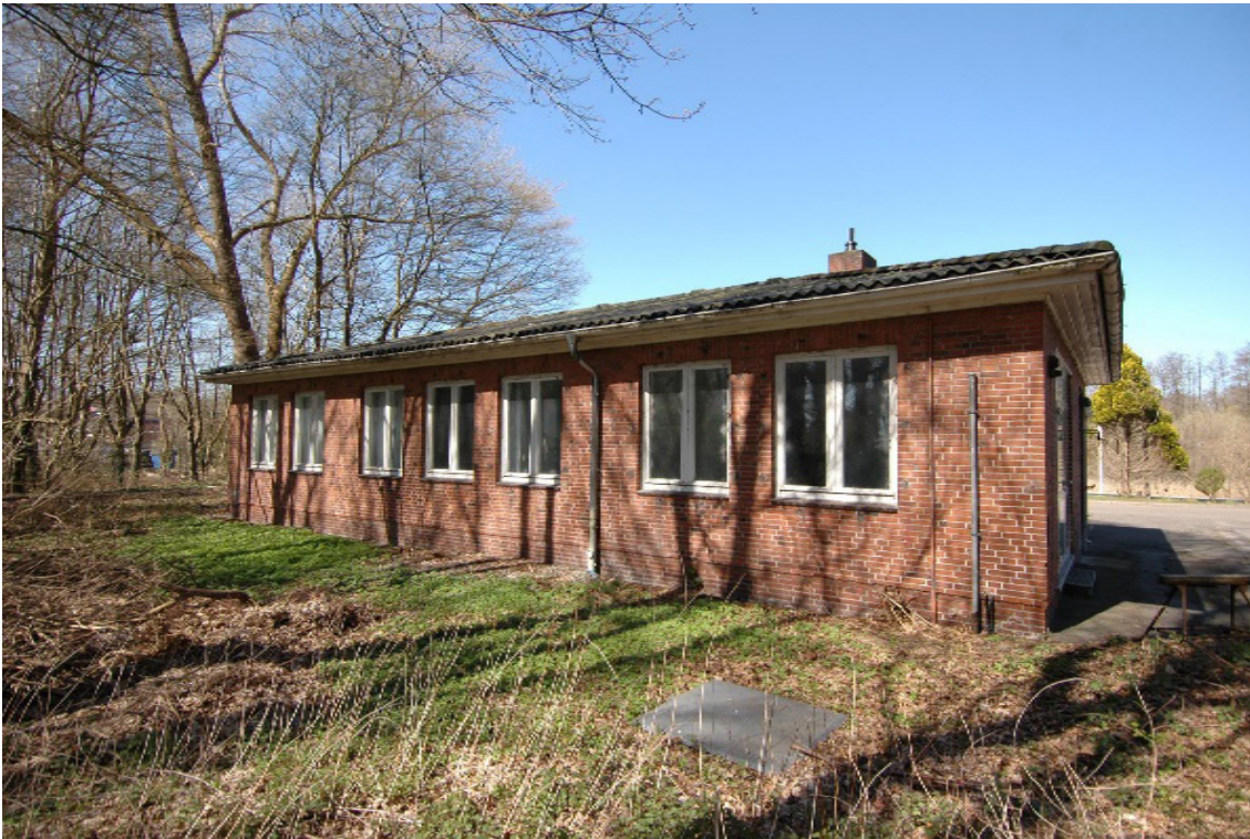
Abbildung 4: Gebäude B1, Schulungsgebäude, Südfassade
