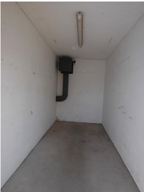
Abbildung 40: Ehemaliges Batterielager, Lagerraum 2
