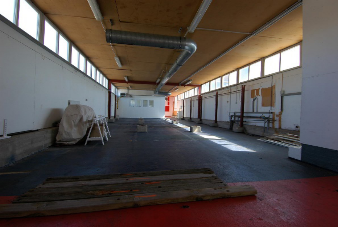
Abbildung 37: Gebäude 4b, Lager, Innenraum
