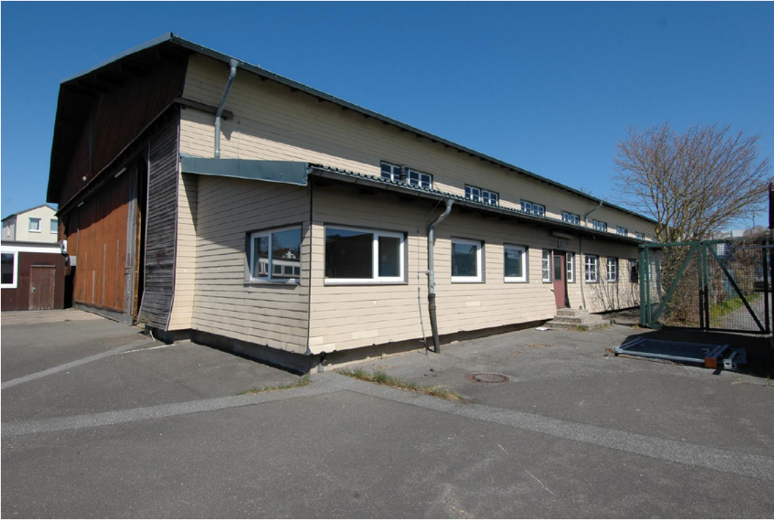
Abbildung 35: Gebäude 4a, Ansicht Süd-West
