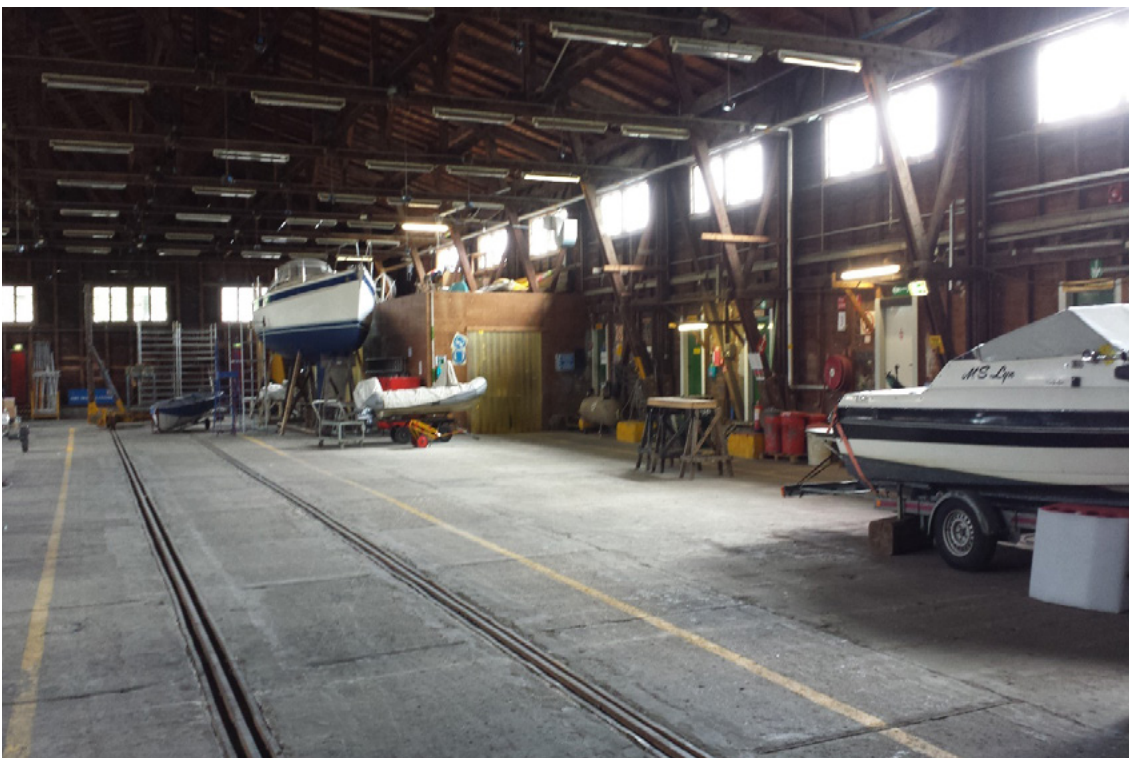
Abbildung 32: Gebäude 4, Holzhalle, Innenraum (2015)
