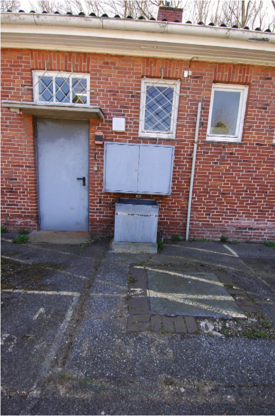
Abbildung 10: Gebäude B1, Schulungsgebäude, Zugang Heizungsraum
