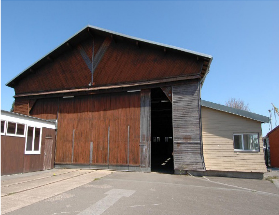
Abbildung 31: Gebäude 4, Holzhalle, Außenansicht
