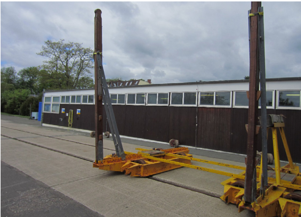
Abbildung 36: Gebäude 4b, Lager, Außenansicht
