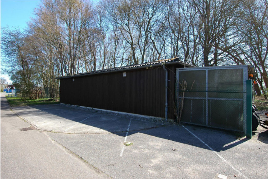
Abbildung 12: B2, Lagergebäude, Nordfassade
