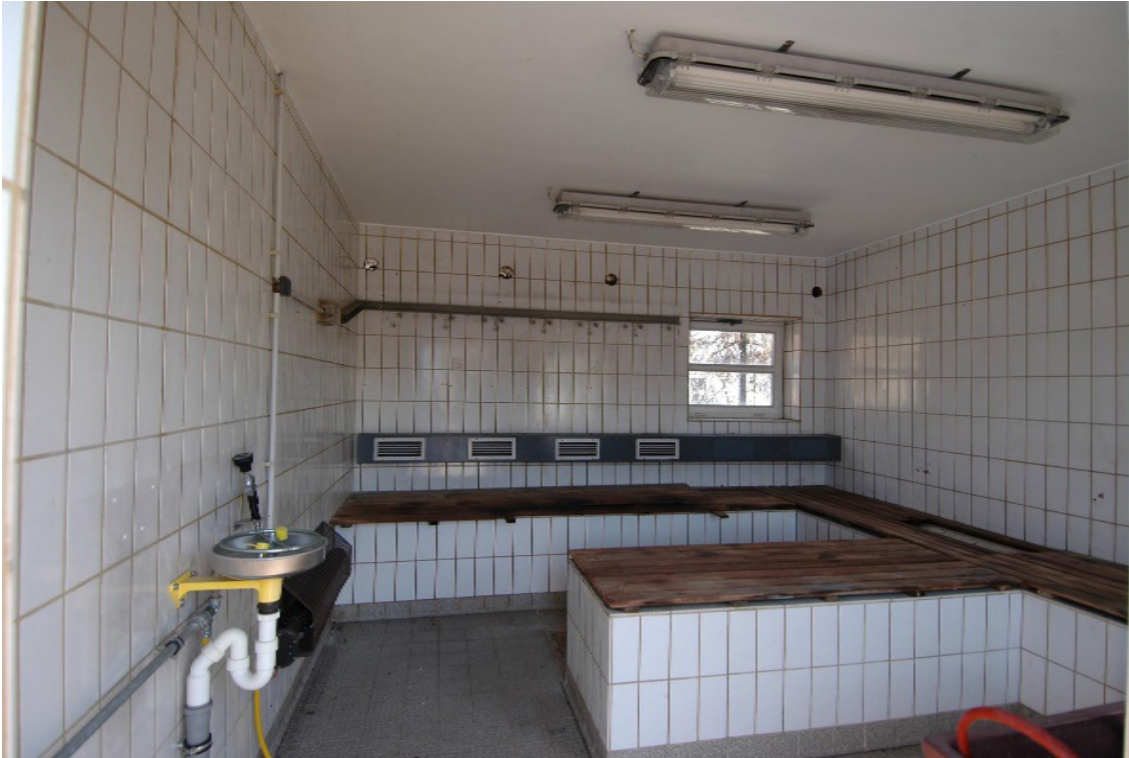
Abbildung 41: Ehemaliges Batterielager, Lagerraum 3
