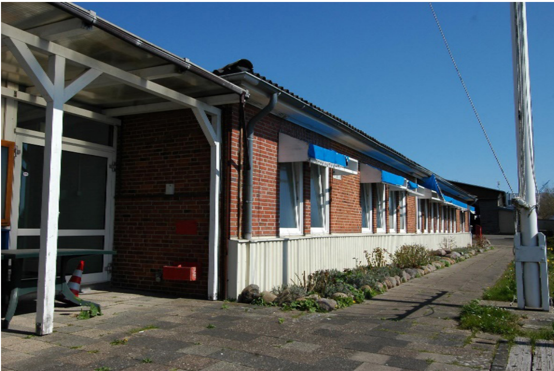
Abbildung 24: Gebäude B3, Bürogebäude, Südfassade
