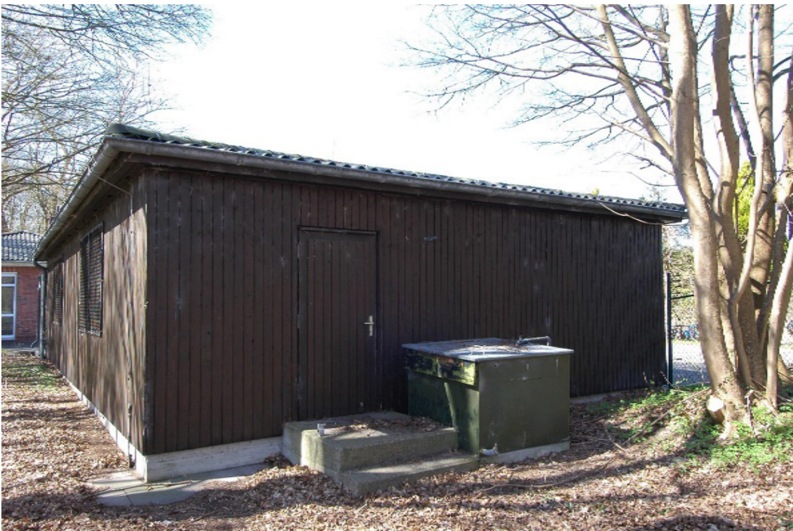
Abbildung 13 B2, Lagergebäude, Ostfassade
