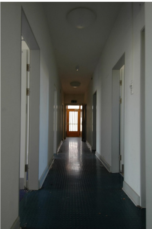
Abbildung 7: Gebäude B1, Schulungsgebäude, Flur
