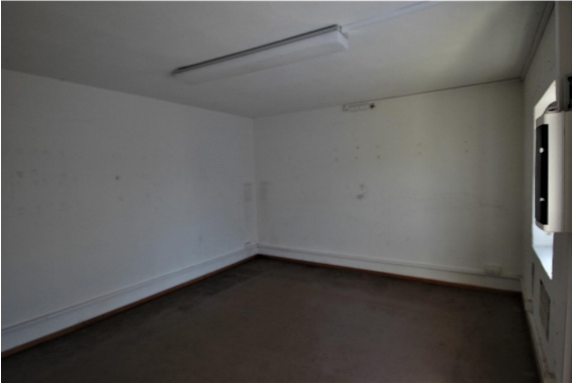
Abbildung 39: Ehemaliges Batterielager, Lagerraum 1
