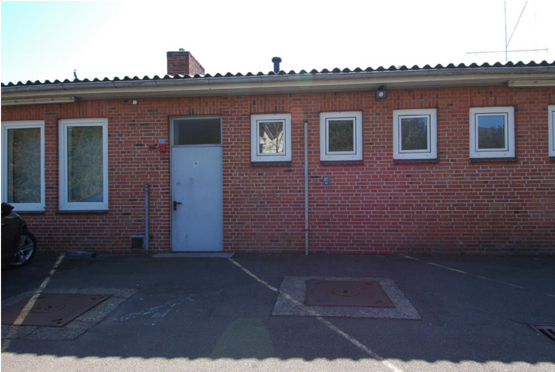
Abbildung 29: Gebäude 3, Nordfassade, Zugang Heizungsraum von außen
