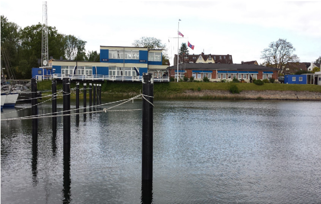
Abbildung 16: Gebäude B3a, Kantine und 3, Bürogebäude, Südfassaden (2015)
