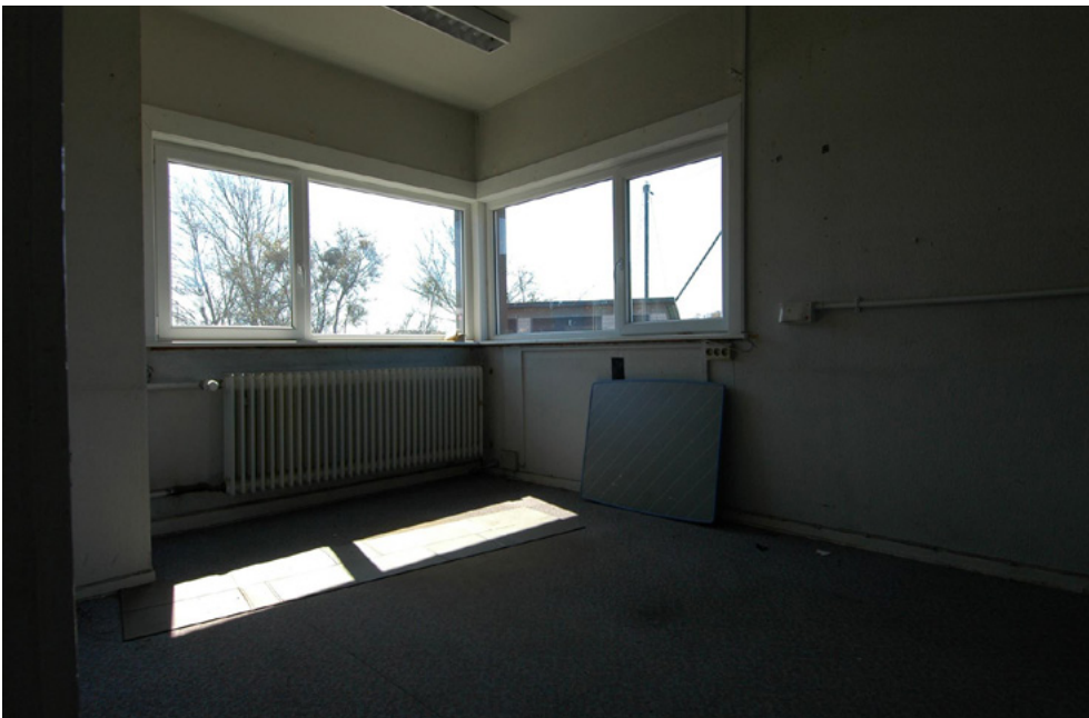
Abbildung 34: Gebäude 4a, exemplarischer Raum
