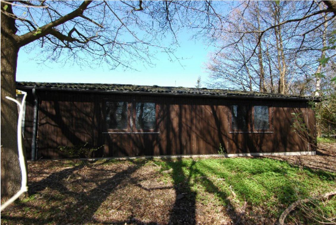
Abbildung 14: B2, Lagergebäude, Südfassade
