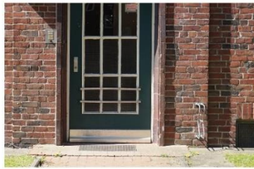
Nicht genügend Plätze für Besucher (Ergänzung zum Fahrradkeller) Nur am Vorderrad anschließbar
