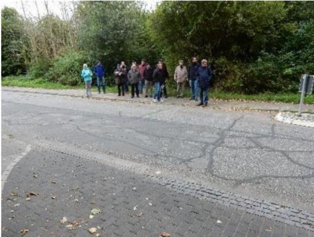
16 Einmündung in den Pfaffensteig und baulich angelegte Fahrbahneinengung (Landeshauptstadt Kiel, 2017 [13])
