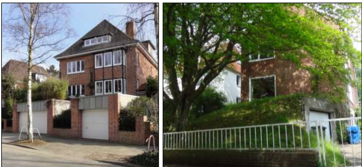
Abb. 50: Garagenbebauung im Vorgarten, rechts Kompromiss zwischen Stellplatzbedarf und Begrünung
