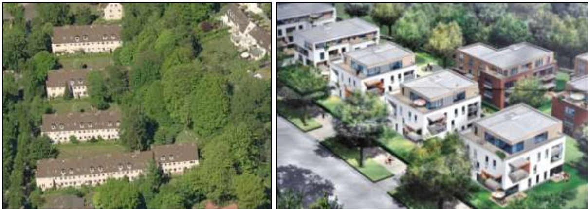
Abb. 31: Moltkestraße 50 - 62 (links Zeilenbauten der 1950er Jahre und Animation der Neubebauung)
