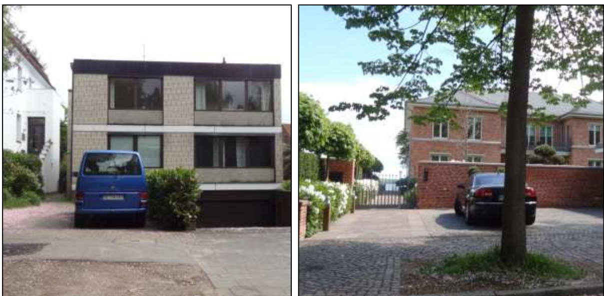
Abb. 49: Vorgärten mit hohem Anteil Versiegelung, rechts wegen Mauer nicht erlebbar,
